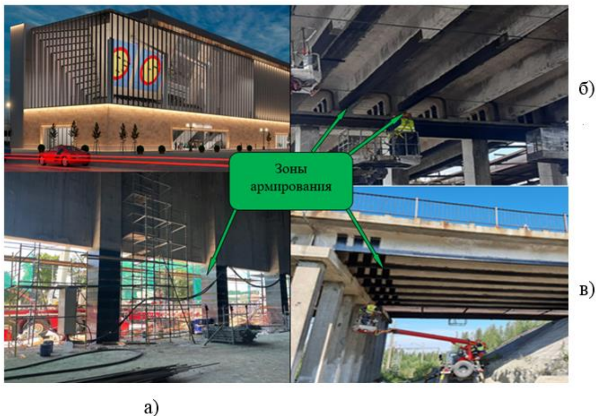
Рисунок 7 – Усиление несущих конструкций Международного центра бокса и самбо Лужниках (а); путепровода в г. Кировске (б) и в г. Череповец (в)
